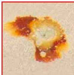
Ejemplo de corrosión de picadura
